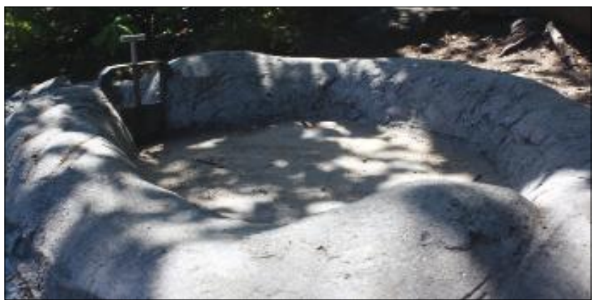
En damm kan också vara permanent på förskolegården, som denna som är gjord i betong och med en dammlucka i stål.
