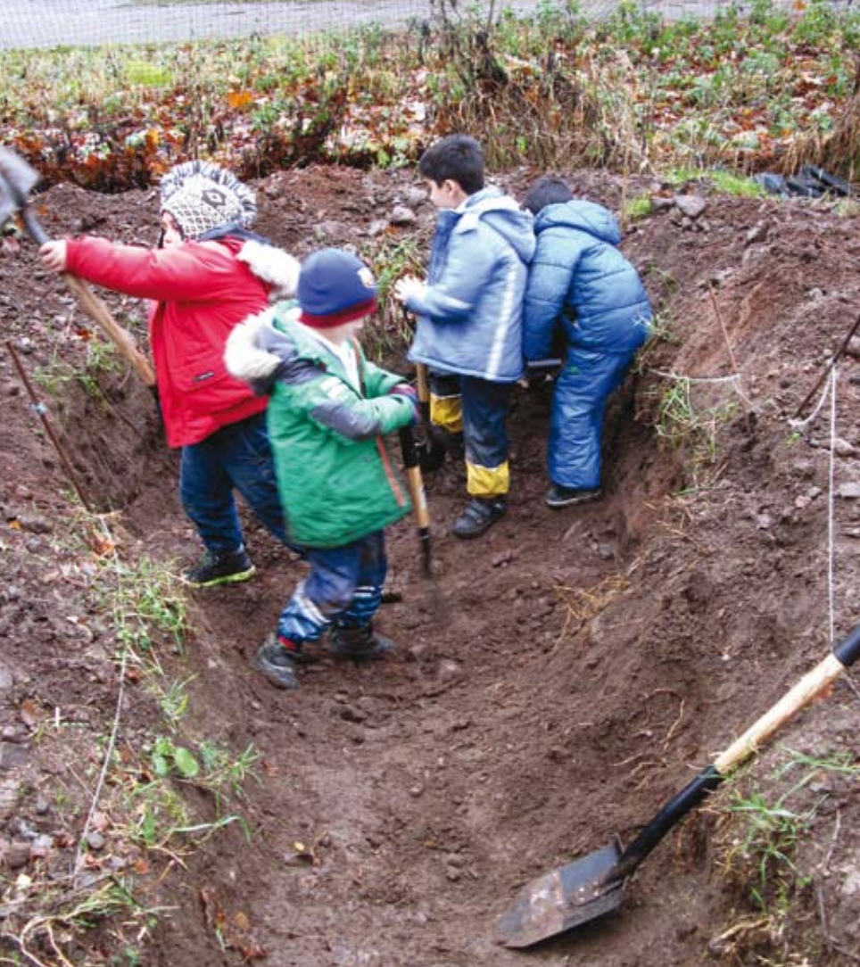
Bygge av jordobservatorium.
